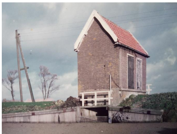
Het gesloopte elektrische gemaal
