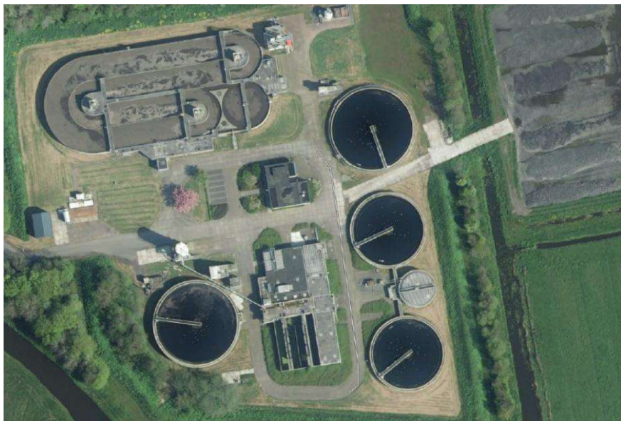
Rioolwaterzuiveringsinstallatie Katwoude vanuit de lucht
